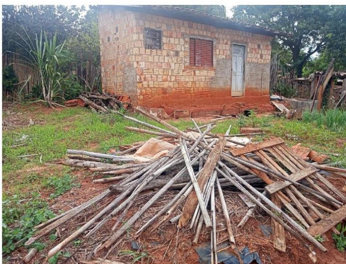
4. Fossa aberta revestida com madeira
