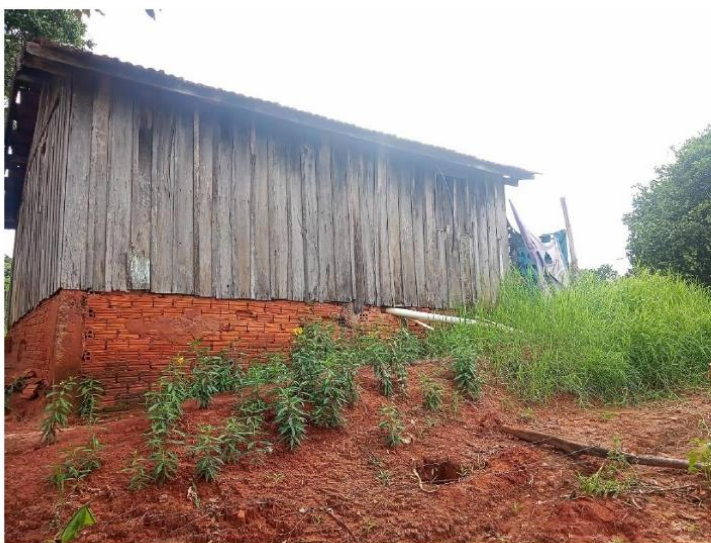
7. Lançamento de esgoto na superfície do solo
